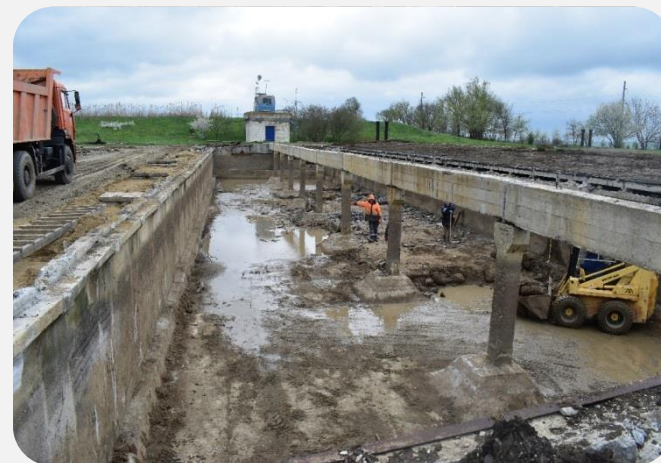
КАПИТАЛЬНЫЙ РЕМОНТ СЕКЦИИ №1 МЕДЛЕННОГО ФИЛЬТРА №1 ПЕРВОЙ ОЧЕРЕДИ НА ОСВ
